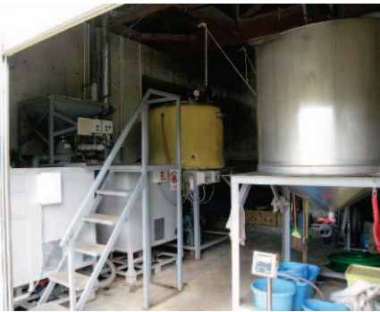
メタン発酵施設
