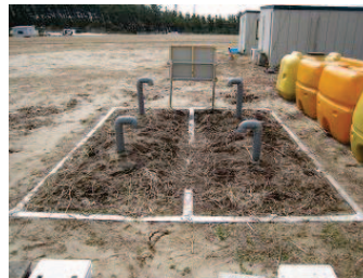
④土壌処理槽
