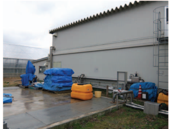
消化液貯留槽（地下式）
