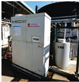
発電・ガス利用
