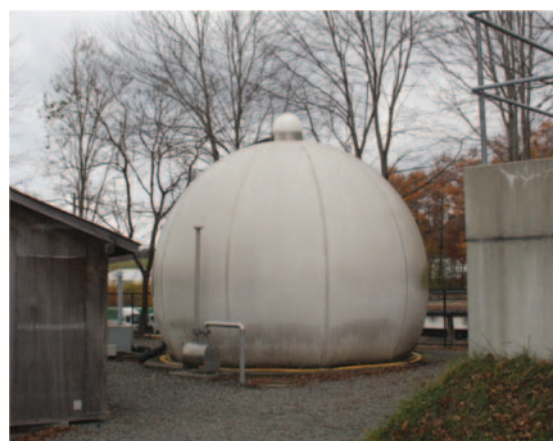
バイオガスホルダー くずまき高原牧場バイオマスプラント
