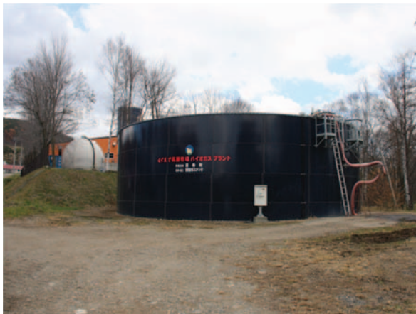
消化液貯留槽
