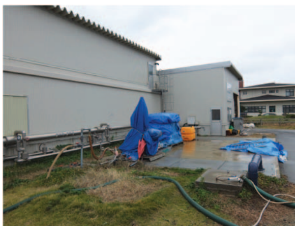
図-3 瀬波バイオマスエネルギープラント
