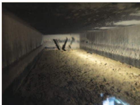
図-4 乾式メタン発酵槽の内部
