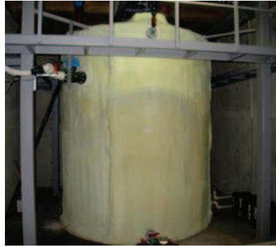
メタン発酵槽
