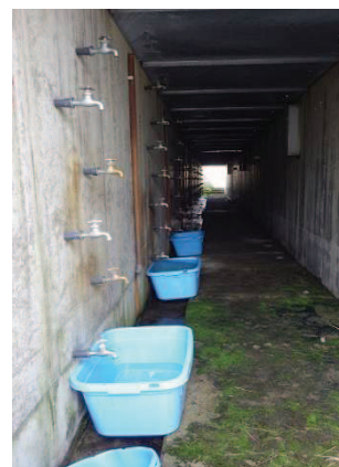
図-43 ライシメーターの地下構造
