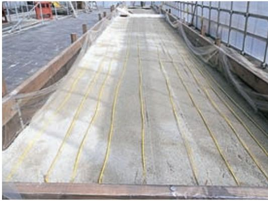
写真IV-4 電熱線（並行型）の敷設例
