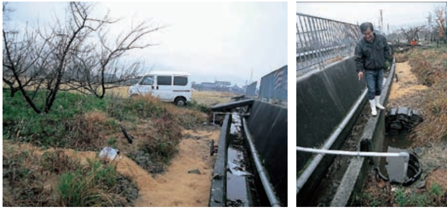
写真Ⅶ-30 水田転換ウメ園は、排水性改善のために暗渠排水を設置したり（左）、高低差がない水路に水を流すため自作のサイホンを設置（右）している（原理は図Ⅶ-9参照）。
