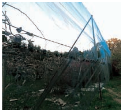
写真VI-15 園地周辺に防風ネットを設置
