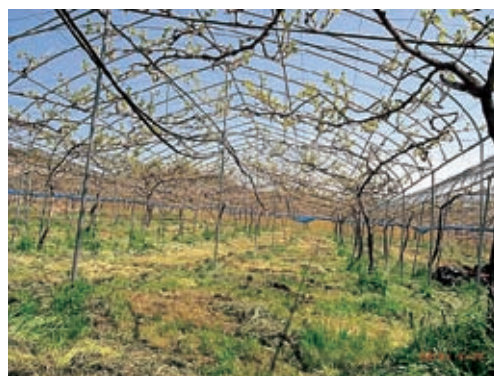
写真V-3 屋根被覆直前のサイドレスハウス
