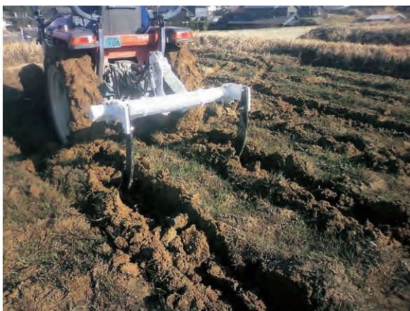
写真 I - 4 弾丸暗渠の施工例（サブソイラー施工） （提供：(財)自然農法センター）
