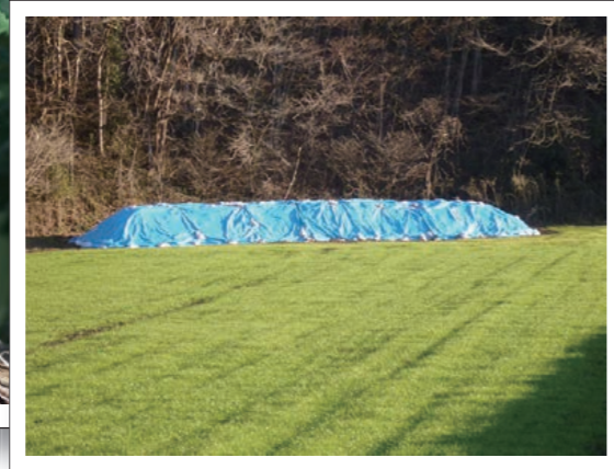
除染作業で排出された土壌の仮置場（福島県） （独）農業環境技術研究所ホームページ 「農業環境と放射能汚染」から
